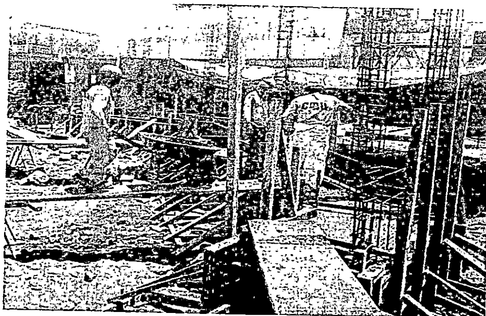
Imagen 6.- Cerco perimétrico zona de fachada, vaciado en cemento corrido.
