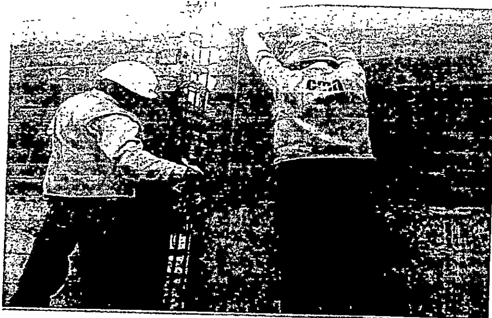
Imagen 22.- Cerco perimétrico - verificación de verticalidad de muro.
