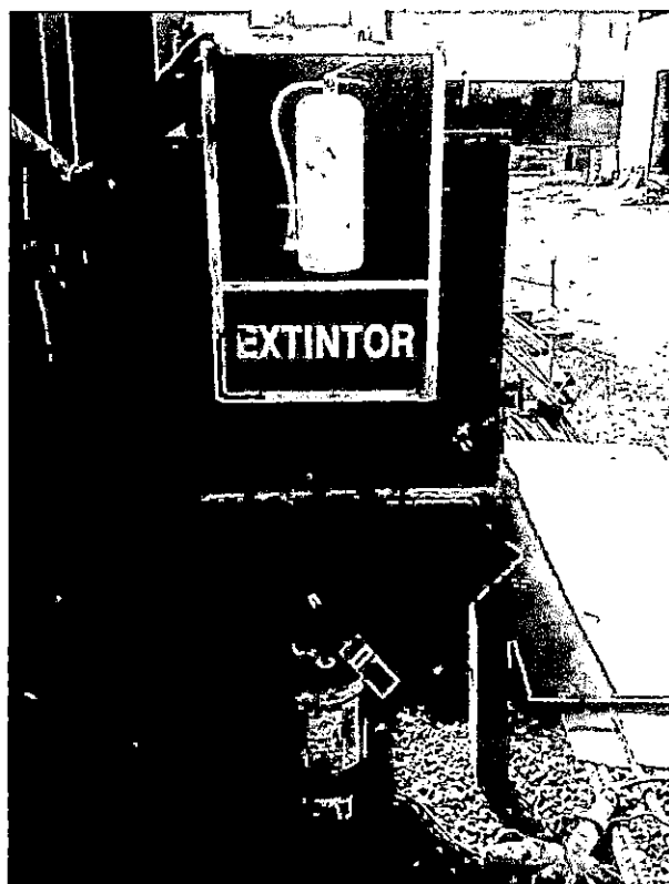
EXTINTOR EN FIERRERIA
