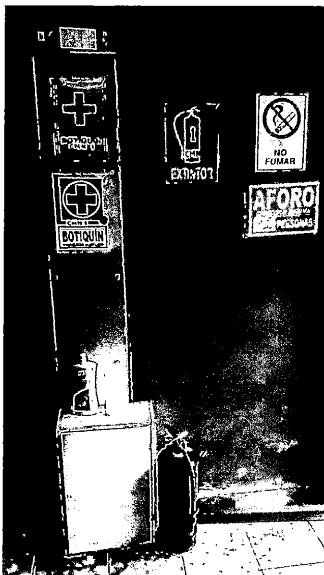
EXTINTOR Y BOTIQUIN EN OFICINA
